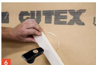
6 Bohrkern entsprechend der Markierung einsetzen und mit Holzbrett und Hammer plan klopfen.
