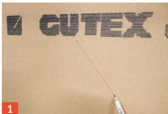
1 Position der Bohrung mit einem Strich markieren, als Anhaltspunkt für korrektes Wiederverschließen.
