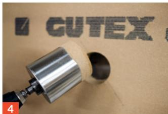
4 Bohrkronen nach hinten ziehen und Bohrkern entnehmen.
